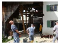
Das historische Wohnhaus bedurfte einer aufwendigen Sanierung. Die Stubentäfelung im Erdgeschoss wurde in ihren ursprünglichen Zustand rückgeführt, alte Bodendielen vorübergehend entfernt und nach dem Einziehen neuer Leitungen wieder verlegt, Fenster nach Restaurierung wieder eingebaut und die Fassade restauriert. Verschiedene Professionisten arbeiteten gleichzeitig. So bot die Baustelle stets ein Bild mit ungewohnt vielen Arbeitern, wie man es aus früheren Zeiten kennt.
